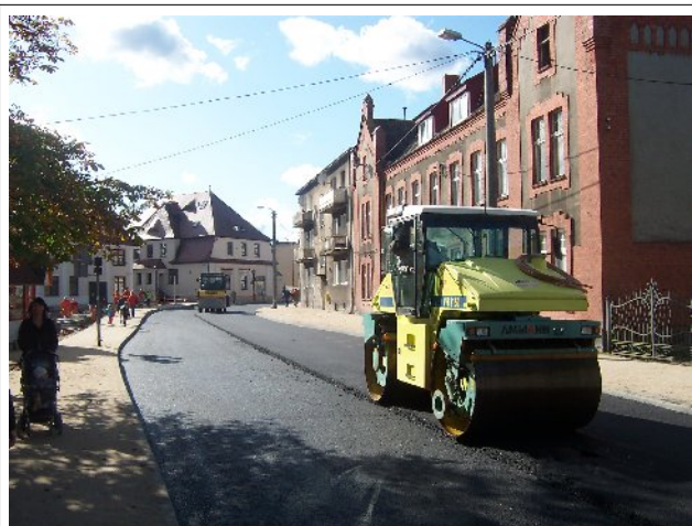
Modernizacja ul. 3 Maja w Kartuzach to jedna z kluczowych inwestycji poprawiających dostępność komunikacyjną i bezpieczeństwo.
