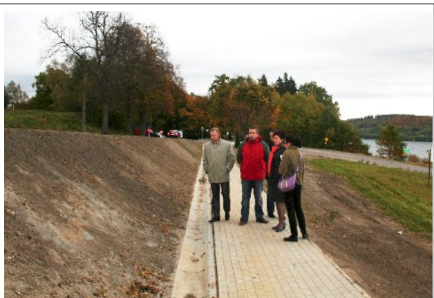
Nowy ciąg pieszcy w Brodnicy Górnej.
