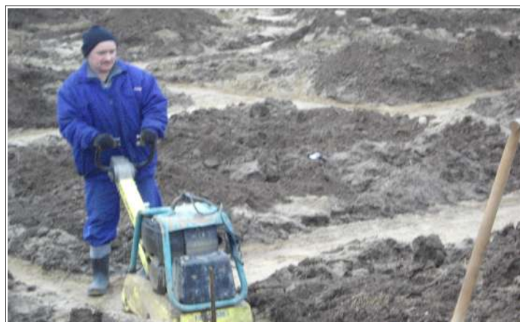
Plac budowy w Kiełpinie
