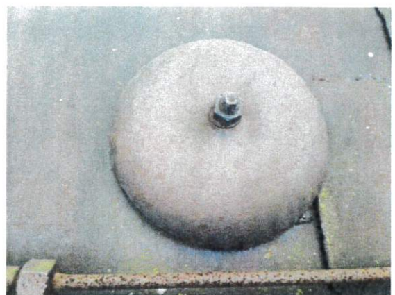
Pokrywa wyczystki w górnej części stojaka
