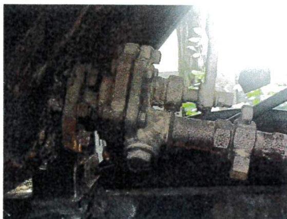
Tylny odmulacz na stojaku kotła
