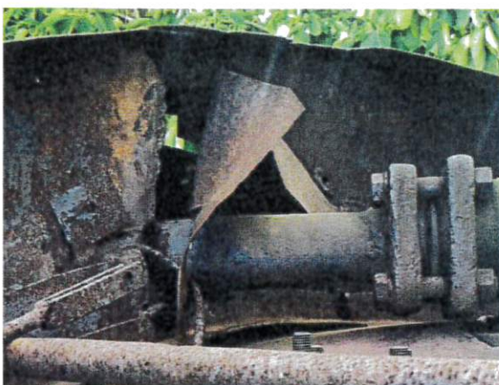
Bardzo zniszczona przednia ściana budki
