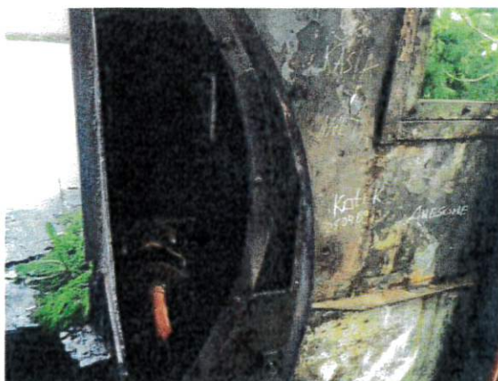
Tylna ściana budki maszynisty
