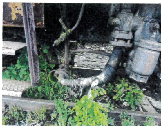
Zniszczone gumowe węże wodne pomiędzy parowozem a tendrem
