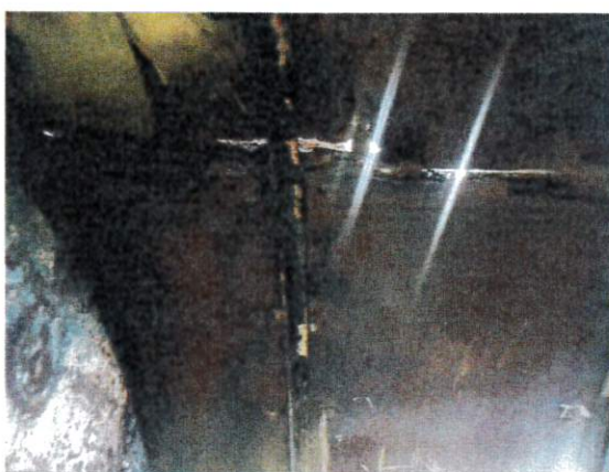
Dach budki widziany z wnętrza budki, perforacja blach
