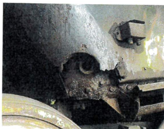
Brak wyczystki w narożniku stojaka
