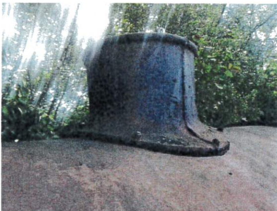
Komin umieszczony na dymnicy
