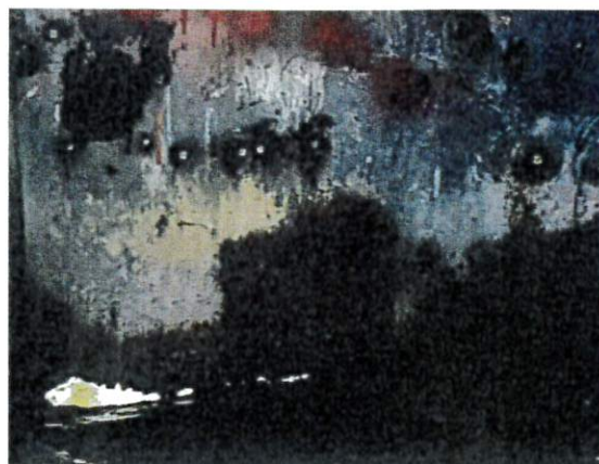
Skorodowana lewa ściana budki maszynisty
