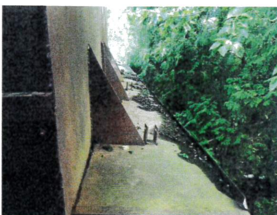
Dach skrzyni wodnej oraz boczna ściana skrzyni węglowej z bocznymi wspornikami
