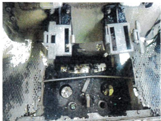
Podłoga przy ścianie drzwiczkowej na wysokości drzwiczek paleniska
