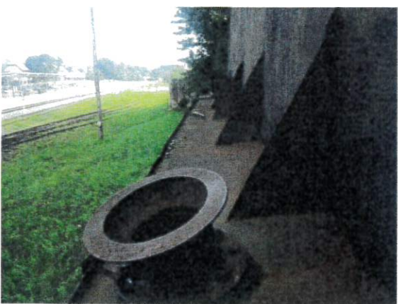
Dach skrzyni wodnej z otworem wlewu środków chemicznych
